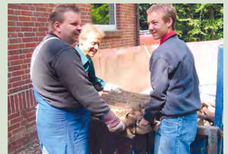
Viel Bauschutt musste bei der Sanierung entsorgt werden.
