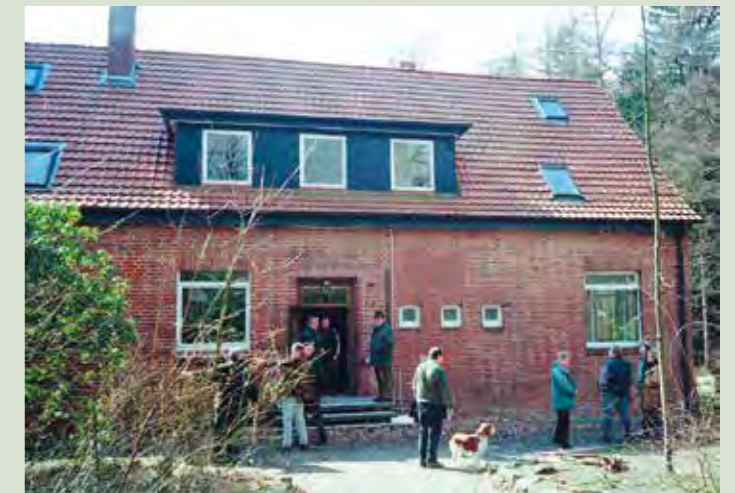
Einer der ersten Besichtigungstermine am und im Gebäude.
